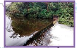
Interligação Rio Itapanhaú (em obras)
